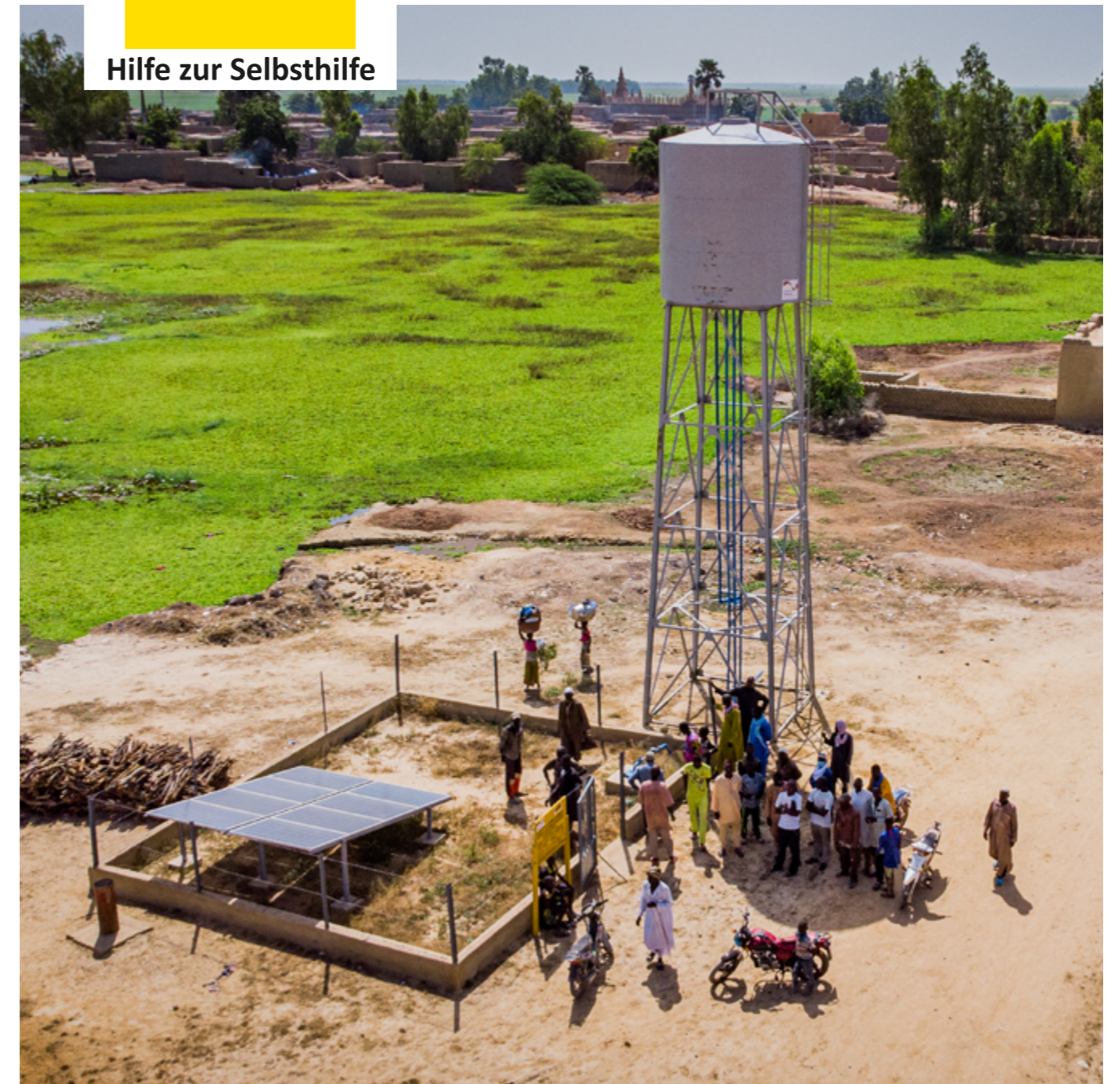
Solarbrunnen helfen bei einer nachhaltigen Wasserversorgung. Mit Solarenergie können Pumpen betrieben werden, die das Wasser aus der Tiefe nach oben befördern.
